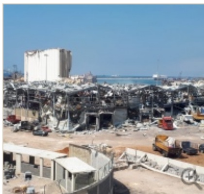
ZERSTÖRUNG AM HAFEN BEIRUTS NACH DER EXPLOSION
